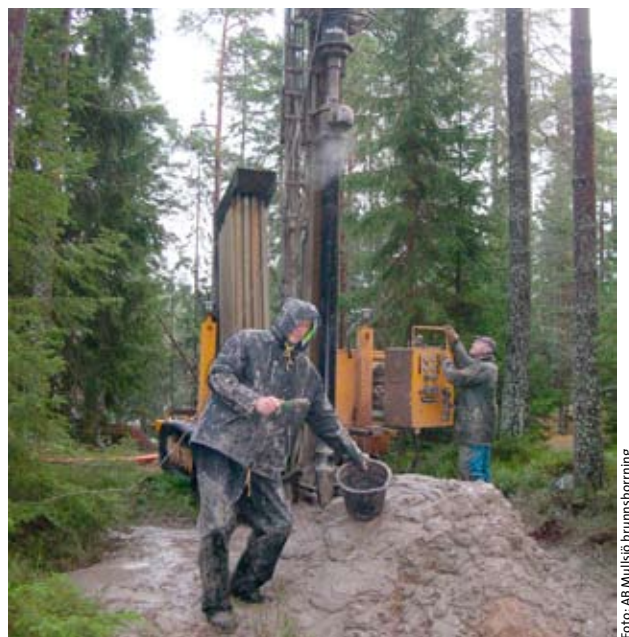
Grundvattenborringar i närheten av sjön Stråken i Mullsjöområdet. Borringarna görs i samarbete med AB Mullsjö brunnborring.
