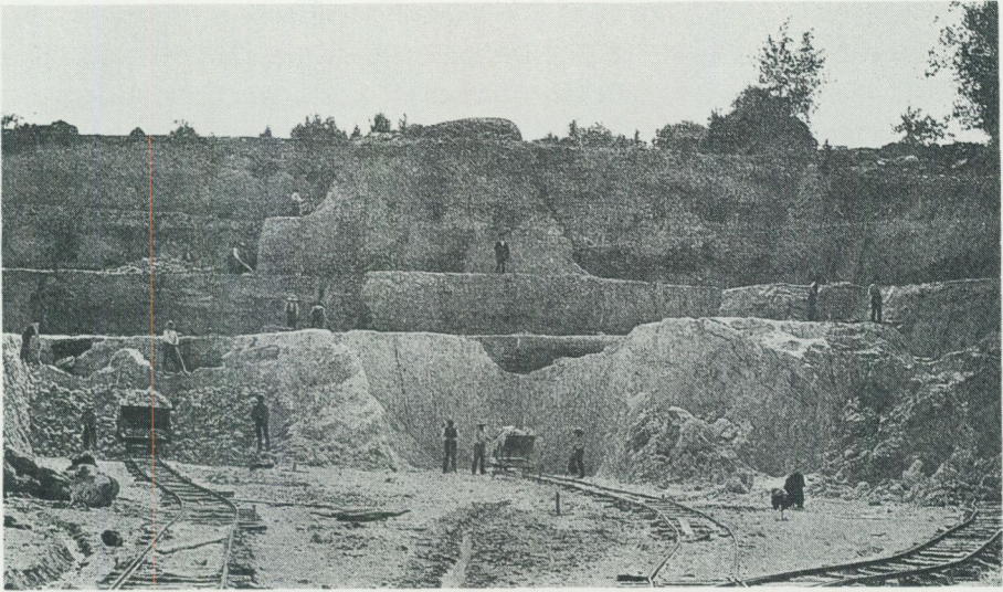
Fig. 12. Bild från "nya kaolintaget" på Ivön, återgiven från Moberg (1903). Det lervittrade urberget innehåller en likaledes lervittrad pegmatitgång. Den ojämna överytan täcks av sand och kalksten tillhörande kritan samt av kvartära jordlager. Brytningen krävde en stor arbetsstyrka.
