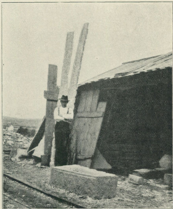
Fig. 11. Bild från en arbetsplats vid Demitz-Thumitz, visande ett par utkilade stycken af granit, mätande 4 m. i längd.
