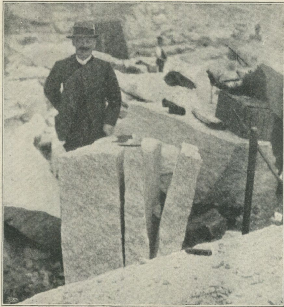
Fig. 6. Bild från det Bartsch'ska stenbrottet vid Striegau, visande granitens utmärkta klyfbarhet i tunna plattor.
