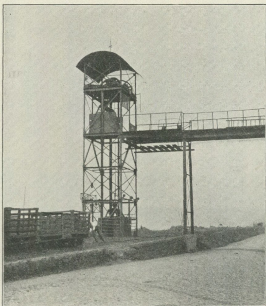
Fig. 31. Transporthiss för basalt vid Linz.
