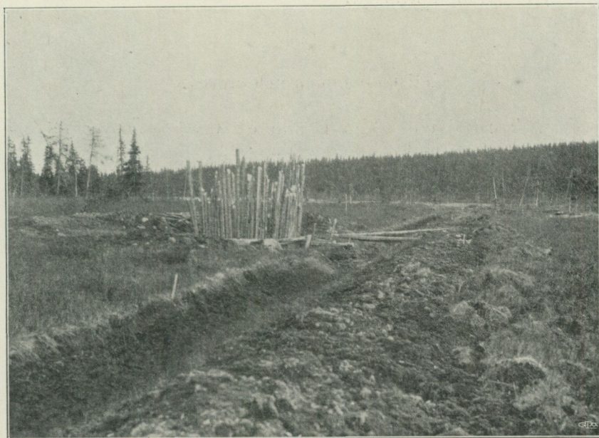
Fig. 24. Dräneringsdike och en med rundvirke inklädd skärpningsgrop, Mänty Vathanvaara.
