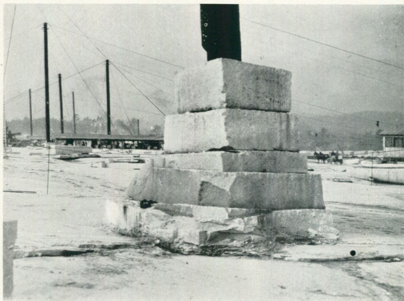
Fig. 97. Mount Airy. N. C. Fundament till kran. Fem block i naturligt läge; fogarna mellan dem äro skjutsprickor. Sid. 91.
