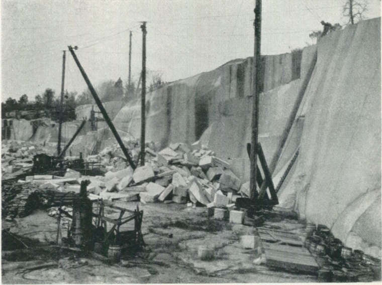
Fig. 67. Andersson Quarry. Rion, Ga. Sprickskjutning längs en 400 m lång och 25 m hög vägg. Sid. 24, 88.
