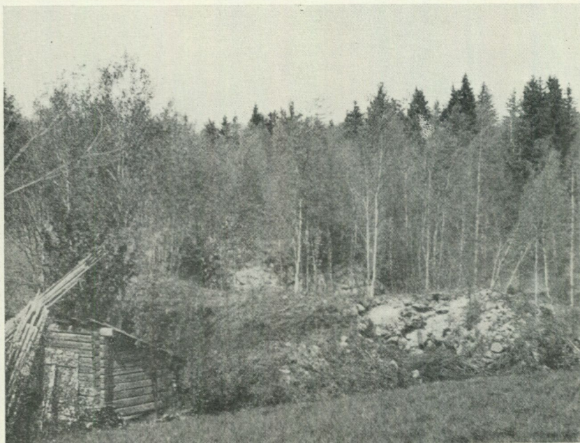
Fig. 23. En bild minnande om en gångens tids kalkbränning inom Siljansområdet. Till höger den delvis raserade fältugnen, i mitten (och bakom) »skäret» i kalkstensbrottet, till vänster kalkboden. Från västra delen av kalkstensförekomsten NO om Östbjörka by.
