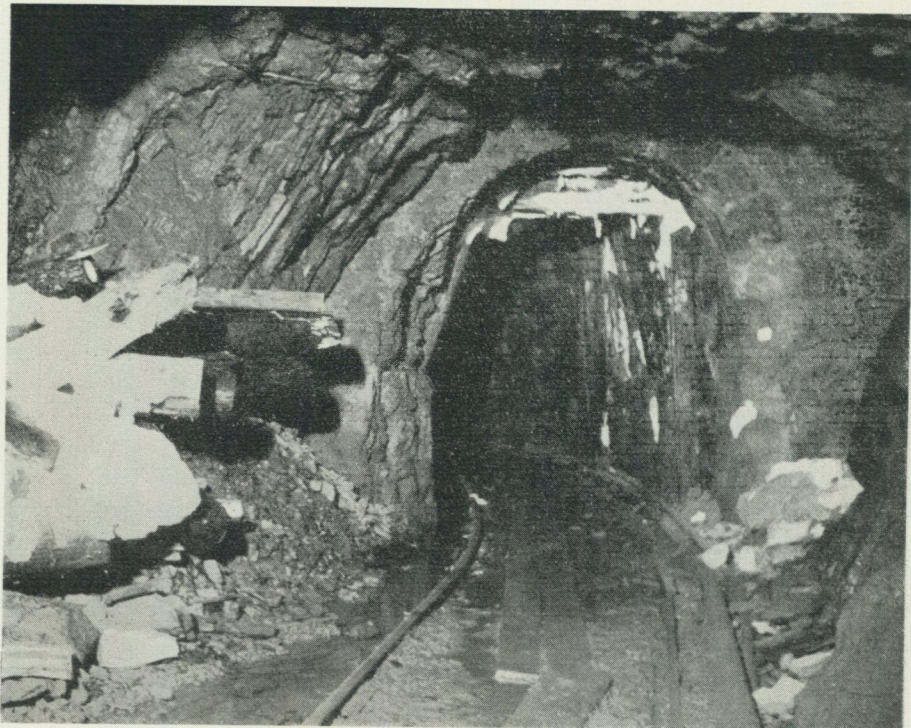
Fig. 38. Gammal ort i Övre Kärrgruvorna på 220 m:s avvägning. Leptitens skiffrighet framträder på bilden.
