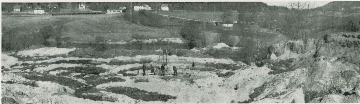
Fig. 10. Säveåskredet från sydöstra skredkanten med Säveån i bildens mitt. De från skredskollorna stänkta, nu söndervitt-rade lerblocken kvarligga på näset vid motsatta stranden, där grässvålsens åt nedströmshållet lutande begränsningslinje, visar åytans läge, då ån bröt igenom de spärrande skredmassorna. Stubbrytaren står vid borrhål 2, som är under arbete. Till höger den kvarstående åbrinken vid skredets nordosthörn och i mittpartiet och till vänster de kvarvarande resterna av de i ån utskjutna lerskollorna. Foto 18/4 45 Carl Caldenius.
