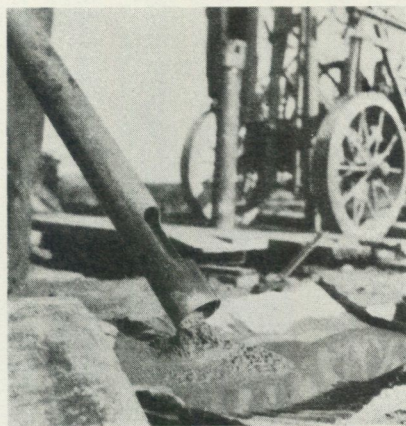
Fig. 3. Provtagningsapparat, s. k. sandpump.
