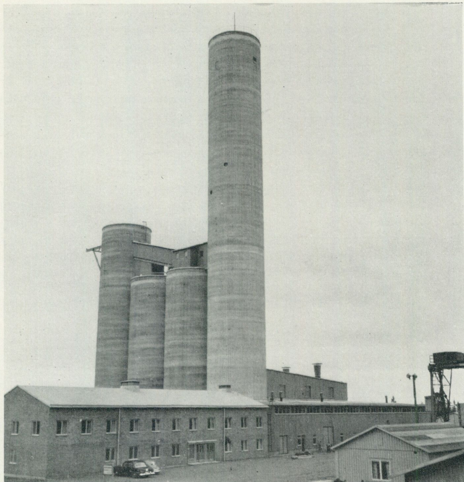
Fig. 30. Vassbo, gruvanläggningen ovan jord. I förgrunden kontor och laboratorium, t. h. verkstad och anrikningsverk, i mitten gruvtorn (70 m högt) jämte malmfickor.
