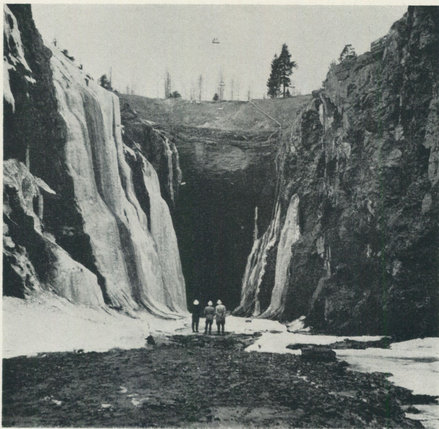
Bild 35. Förskärningen till avloppstunnelns nerströmsände (berggrund: ådergnejs och grå granit) Stornorrfors kraftstation mellan Vännäs och Umeå. Foto P H Lundegårdh 1958. ©
