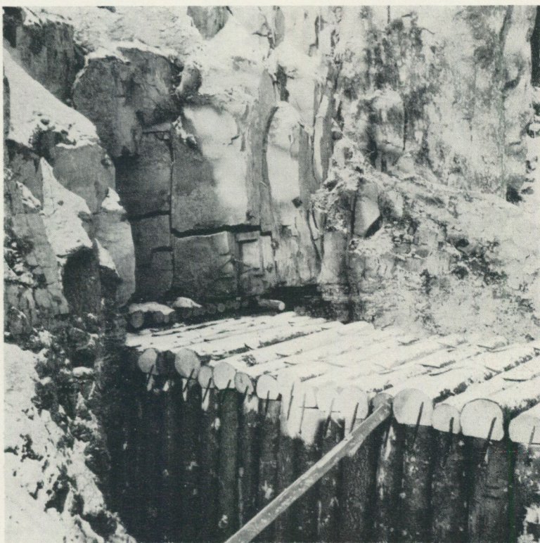
Bild 56. Bockort till skydd mot ras framför påslag till tunnel i lerskiffer under diabas. Billingen SV om Skövde. Foto P H Lundegårdh 1962. ©
