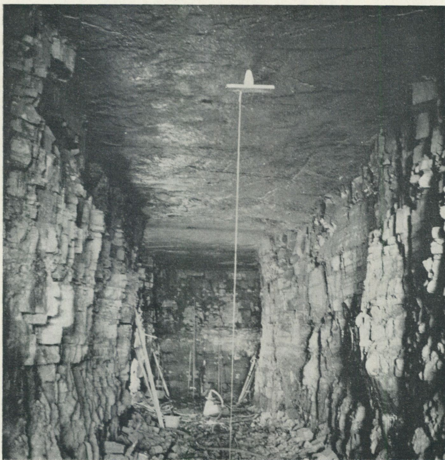
Bild 33. Kambrosilurisk lerskiffer (tunnelns väggar) täckt av diabas (lagergång = tunnelns tak). Billingen SV om Skövde. Foto P H Lundegårdh 1962. ©
