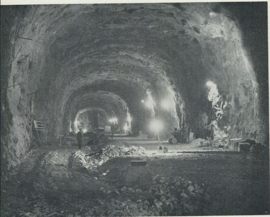
Bild 53. Tunnel med halvcirkulär tvärprofil genom gnejs. Från utsprängningen av garaget i Katarinaberget, Södermalm, Stockholm. Foto IC Stockholm.
