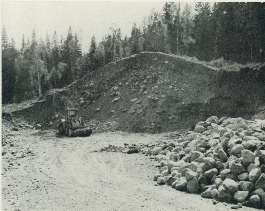
Fig. 29. Skärning i Augerumsåsen, 10,5 km NO om Augerum k:a. Åskrönet är beläget ca 70 m ö. h. Bakom maskinen syns ett stort block.
