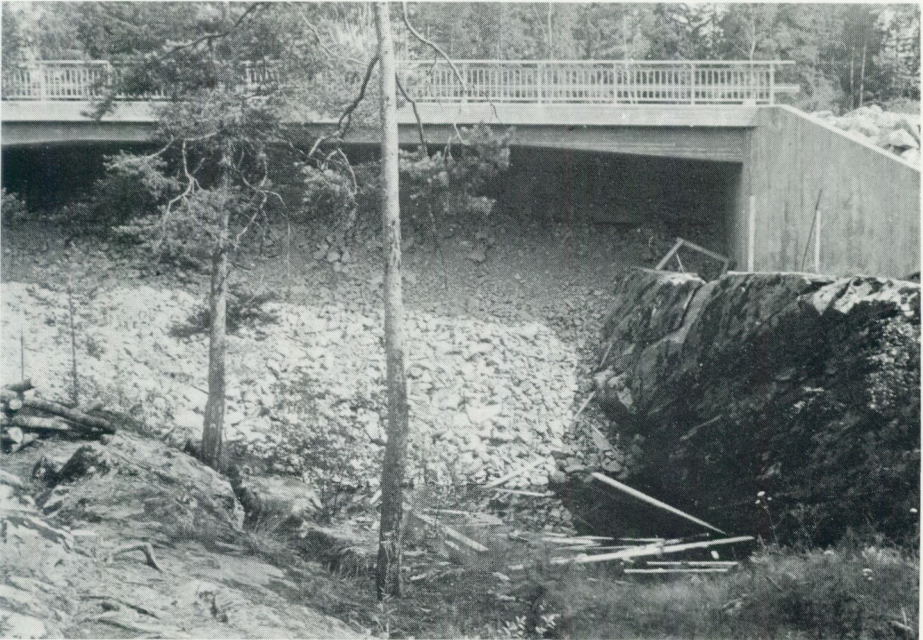
Fig 13. Södra Helvetet nedströms mot betongvalvet och stenfyllningen. Jämför Fig 10. Foto E Fromm 1972.
