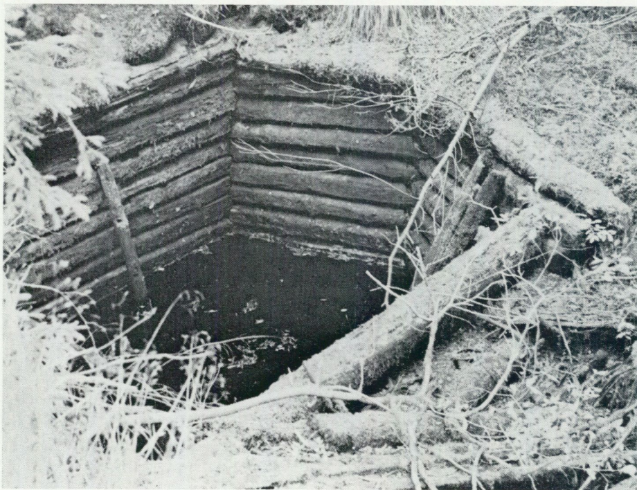
Fig. 6. Förtimringen vid det näst sydostligaste gruvhålet, Stenby gruvor, Vattholma. Foto E. Åhman 1967.
