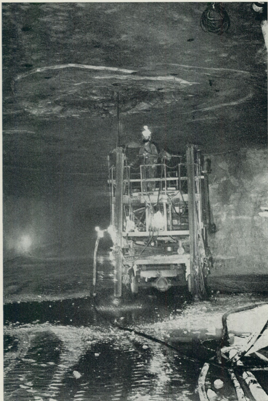
Fig. 8. Undersökningsborrning i strukturen på fig. 6. Exploratory boring in the structure of Fig. 6.
