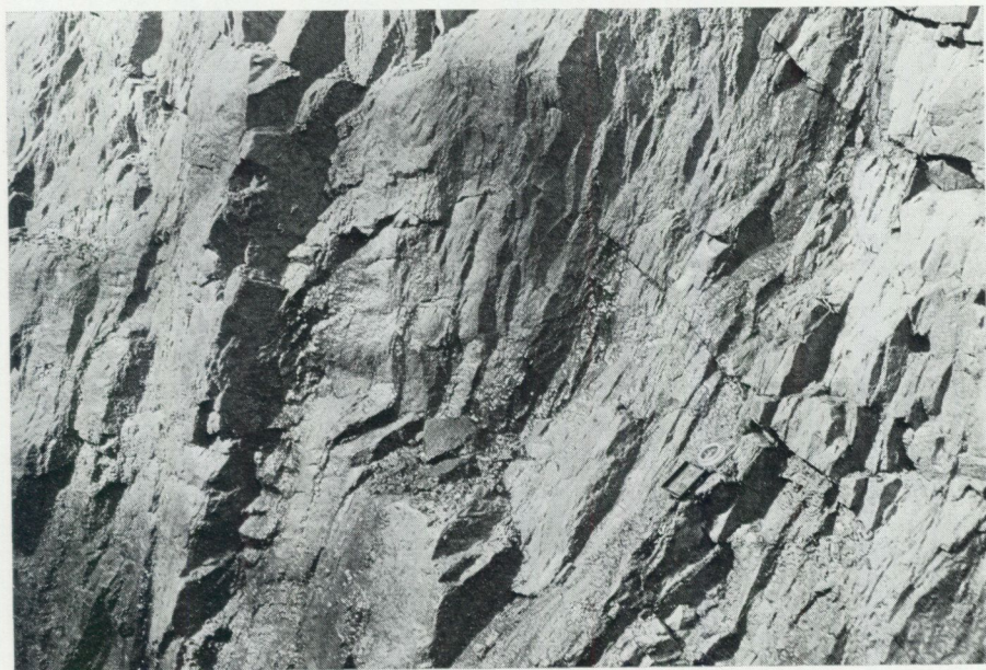
Fig. 8. The structure of the paragneiss with water-bearing fissures parallel to the schistosity of the rock. (Photograph by G. Hansson.) Sedimentgnejs med vattenförande sprickor parallella med bergartens skiffrighet.
