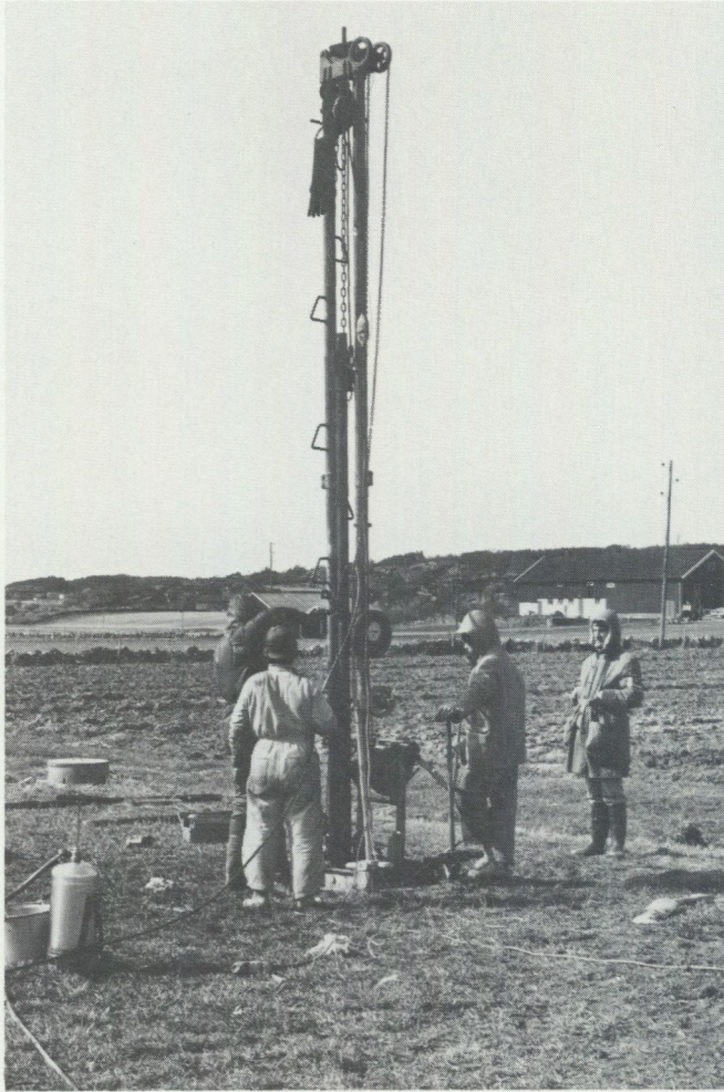
Fig. 4:2. Taking of one of the Foil Piston Cores at Solberga (N. Knaverstad) on April 14th, 1977.
