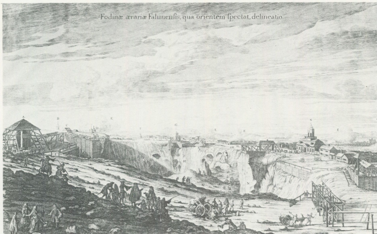
A Trochlea ad cavernam, Regiminis nomine insignitam, Suedice Regerings Schafv mind. B. Aquæ ductus, ubi collecta in cisternis aqua egeritur, Suedice Rufft Stugu. C. Trochlea, quæ jumenta circumagitur, ad cavernam à Rege CAROLO XII dictam, altitudine LX hexapedum seu ulnarum. D. Petrochium, seu machina tractoria ad cavernam nomine Regine Ulalricæ Cleonoreæ appellatam, et LX ulnas profundam. E. Furnus ex officinis molliendo metallo extructus, Suedice Kallrostar. F. Vetus Curia metallicorum. G. Petrochium ad cavernam, quæ columna candida dicitur, vulgo Blankföten, XL ulnarum profunditate. H. Caverna columnæ candidæ 35 ulnarum. I. Trochlea arcularum, Suedice Sifferminden, si uln. K. Curia nova conventus metallicorum constituta. L. Trochlea ad cavernam lignariam, 70 ulnarum. M. Caverna à CAROLO XI dicta, per subterraneos meatus 127 ulnas depressa. N. Lignientum magnum e columna candida delapsum Anno 1687.
