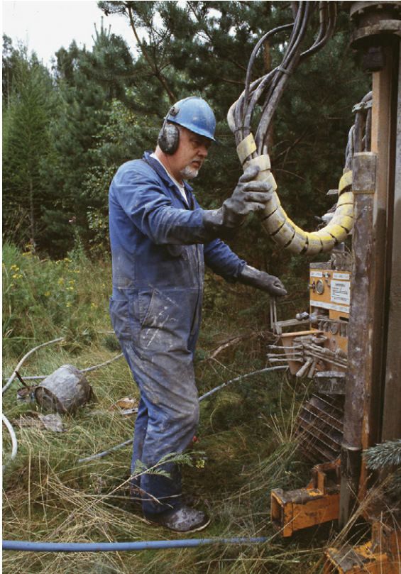
Fig. 33. Drivning av observationsrör SGU 9903. Foto: A. Damberg.
