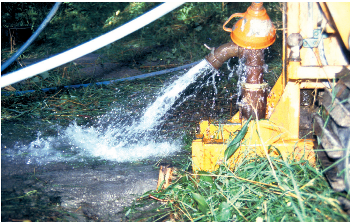
Fig. 7. Rensning är en viktig del i samband med etablering av observationsrör och rörbrunnar. Härvid spolas det finkorniga jordmaterialet upp till ytan och ett filter byggs upp omkring rörspetsen eller brunnens filterdel. Efter rörrensningen företas i förekommande fall provpumpning i röret eller brunnen. Foto: C.-F. Müllern.
