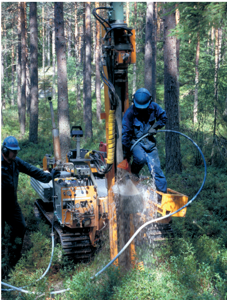
Fig. 5. När de geofysiska mätningarna avvägts och utvärderats genomförs borrhningar på de optimala platserna. Därvid undersöks och provtas sammansättningen av såväl jordlagren som grundvattnet allteftersom borrhningen drivs djupare. Foto: C.-F. Müllern.
