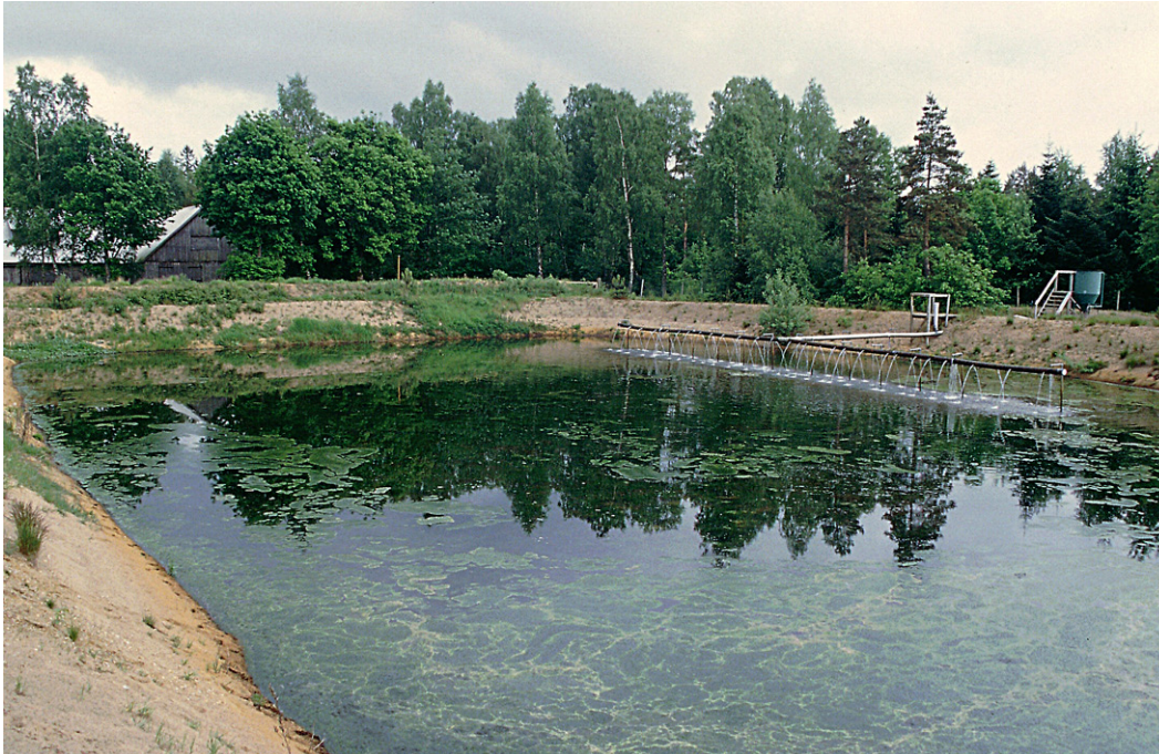
Fig. 8. Den östra av infiltrationsdammarna vid vattentäkten vid Tollsjo. Vattnet som infiltreras är från Rössjön ca 400 m bortom träden i bakgrunden. Foto: C.-F. Müllern.
