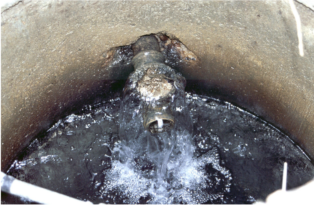
Fig. 16. Den ursprungliga källan vid St. Tingberga, 4,5 km söder om Munka-Ljungby, är sedan länge övertäckt. Vattnet leds i ett rör in i cementringar och vidare ut och åter i rör. Flödet är 5–10 l/s. Foto: C.-F. Müllern.
