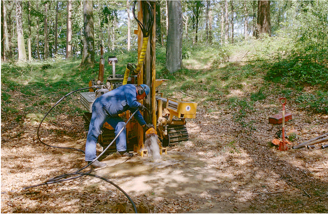
Fig. 10. Från borrhningen av R 0202. Vatten tas upp från 26–27 m djup vid udden norr om Kyrkesjön. Foto: C.-F. Müllern.
