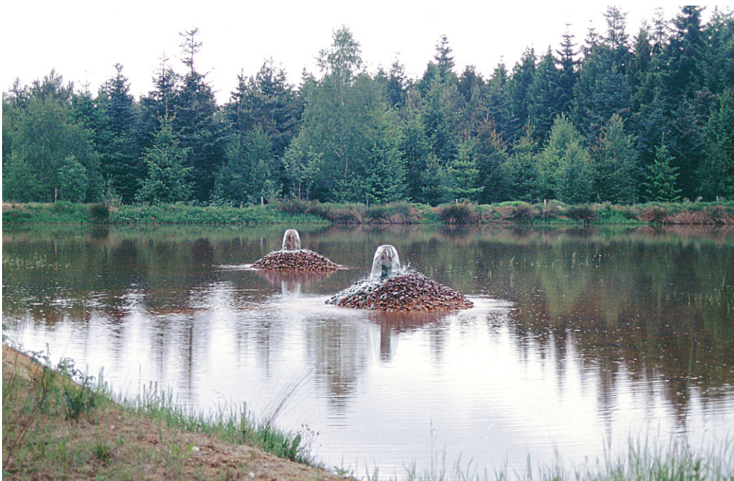
Fig. 9. Den västra av infiltrationsdammarna vid Tollsjo. Uttagsbrunnar finns mellan dammarna och ca 100 m nordöst om dammarna. Foto: C.-F. Müllern.
