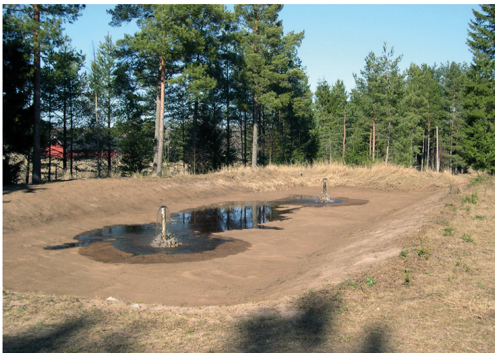
Figur 10. Infiltrationsdammar vid den kommunala vattentäkten vid Storehagen.
