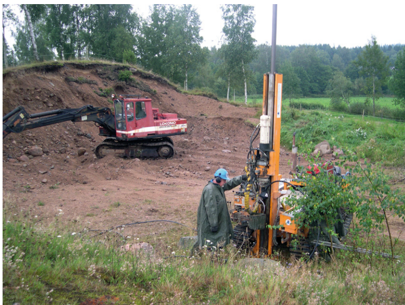
Figur 6. Drivning av observationsröret R04102 invid en mindre åsrygg ca 500 meter sydväst om Brolycke. Borrpunktens läge framgår av figur 2.
