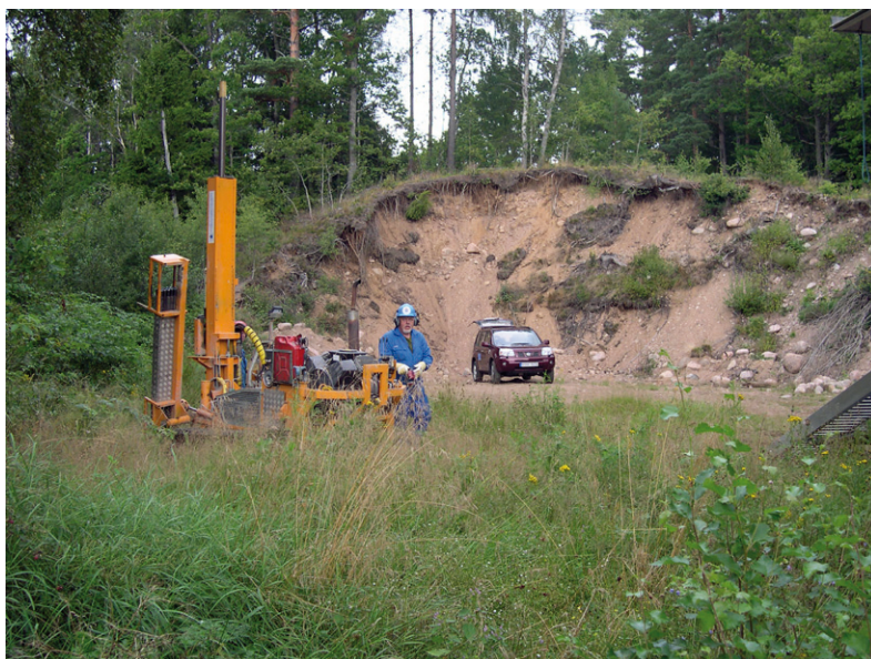
Figur 5. Drivning av observationsröret Ro4100 i en liten åsrygg ca 900 meter nordost om Storsjön.
