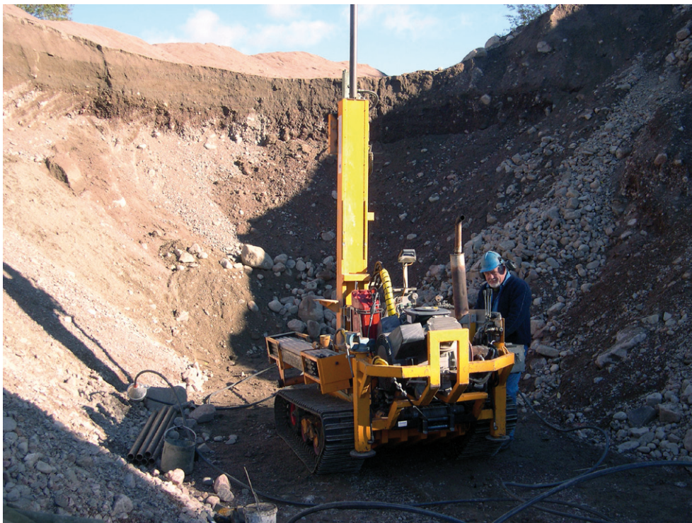
Figur 7. Drivning av observationsröret R0302 i grustäkten som ansluter till den seismiska profilen S11-03 (profilens läge är angiven i figur 3).
