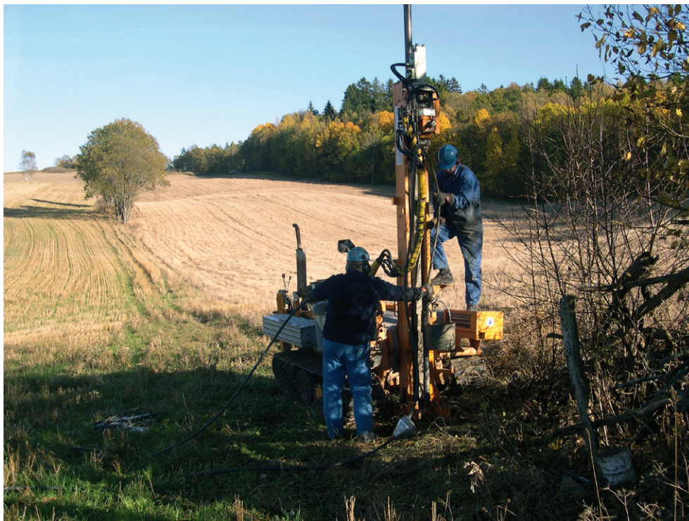
Figur 10. Drivning av observationsröret Ro4093 nära Brogården. Läget framgår av figur 3.
