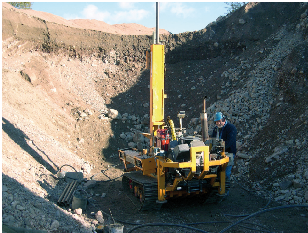
Figur 7. Drivning av observationsrör Ro302 i grustäkten som ansluter till den seismiska profilen S11-03 (profilens läge är angiven i figur 3).
