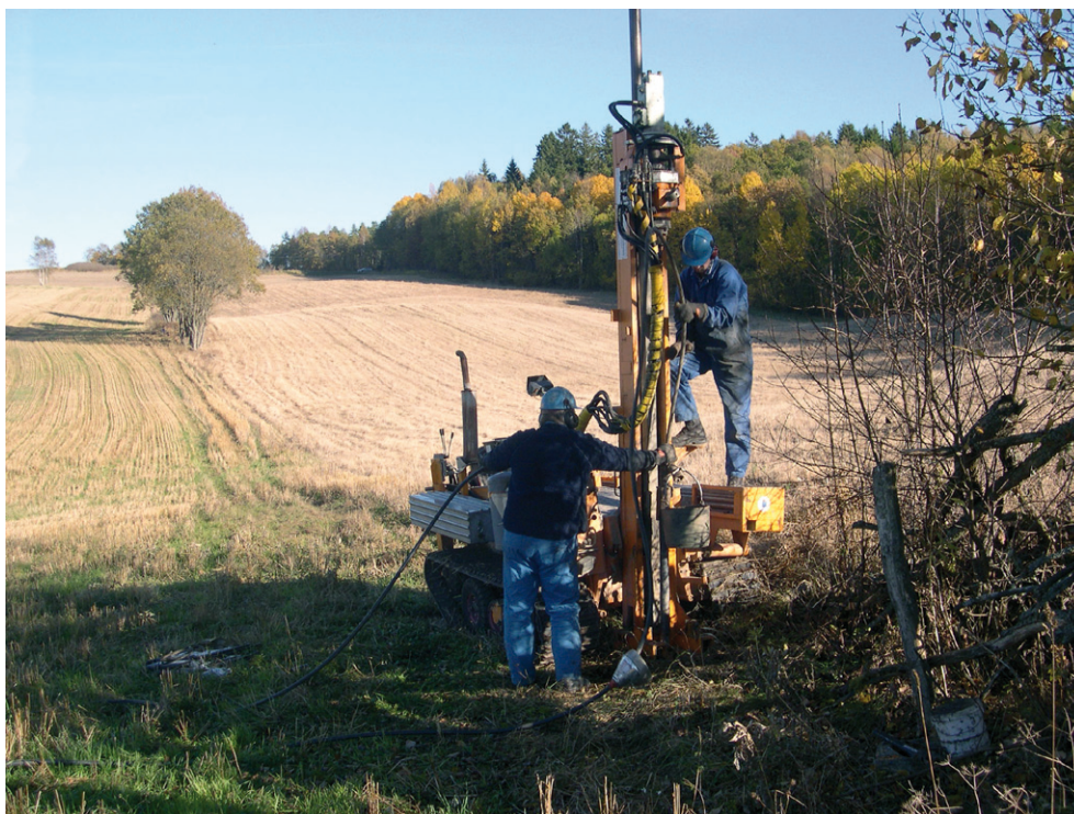
Figur 10. Drivning av observationsrör Ro4093 nära Brogården. Läget framgår av figur 3.
