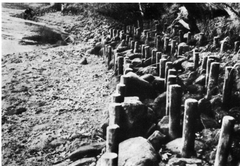
Fig 6. Resterna av en gammal strandskoning, en s.k. mjågbyggnad, utmed Österdalälvens strand vid byn Öna. Foto: Ragnar Lannerbro 1948.
