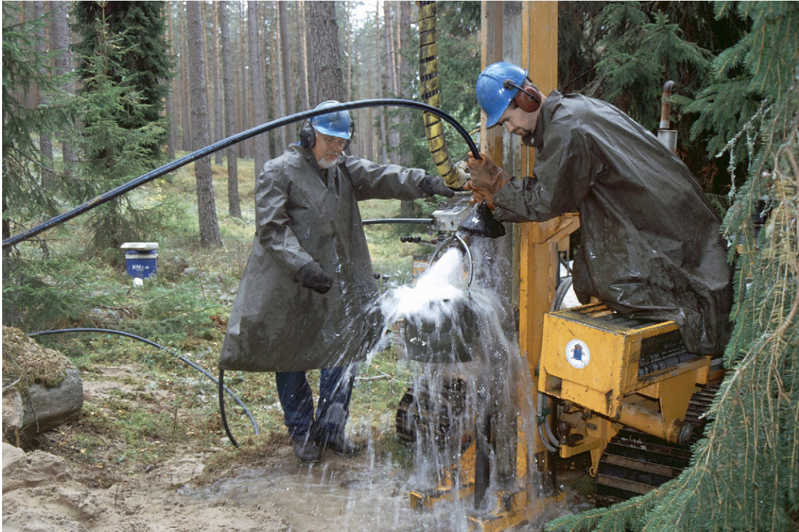
Fig. 30. Vid borrhningen R 0301, i början av den seismiska profilen S 2-03, påträffades grövre, starkt vattenförande lager fr.o.m. 25 m till 51,6 m, i detta fall bormaskinens begränsningsdjup. De understa ca 30 m av grundvattenmagasinet är således av okänd karaktär. Foto: Carl-Fredrik Müllern.
