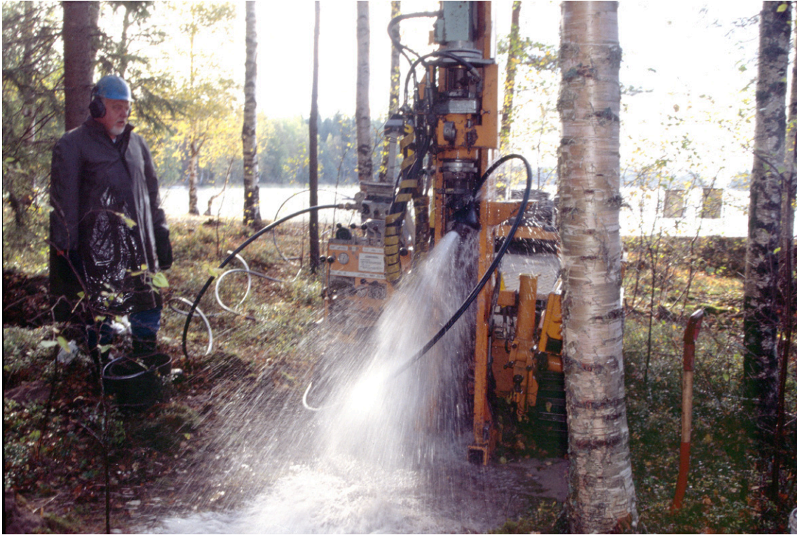
Fig. 28. Från borrningen av R0305, vid Tobakshålet. Sand- och gruslagren var starkt vattenförande med hög genomsläpplighet. Vattnet klarnade mestadels mycket fort, vilket tyder på mycket litet inslag av silt- och lerpartiklar i grundvattenmagasinet. Foto: Carl-Fredrik Müllern.
