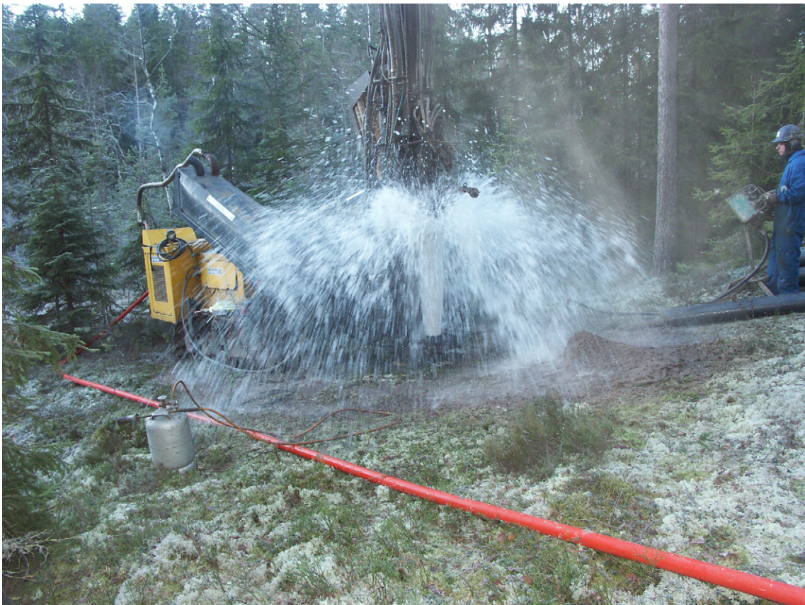
Fig. 32. Från borrhningen av R04172 vid 110 m i den seismiska profilen S13-03, vid Ångsågen. Mellan 12 m och 39 m påträffades sand och grus. Vattenföringen var ovanligt stor mellan 15 m och 33 m, där lagren var övervägande grusiga. Foto: Carl-Fredrik Müllern.
