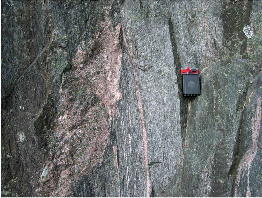
Fig. 3. Kraftigt deformerad tidigorogen monzogranit. Bergkvalitetsklass 1 (väg). DCL041085 (6484373/1503911). Foto: Dick Claeson.
