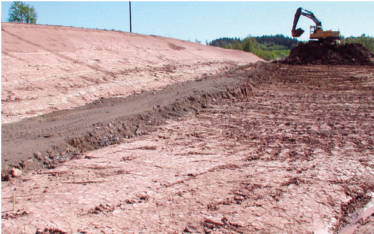
Fig. 3. Mer än 5 m glacial, röd, varvig lera (s.k. bergslagslera) har blottlagts vid grävningsarbeten för väg nr 205 vid Östra Kärne (8f). Foto: J.-O. Svedlund.
