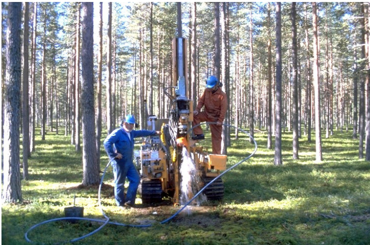
Fig. 11. Vindelälvsåsen vid Haddingen. Drivning av observationsrör och rensumpning vid R 9802. Under 8 meter grovmo följer mellansand, grovsand och fingrus till 27 meter djup. Borrningen är ej nedförd till akviferens botten. Foto: T. Wikner.
