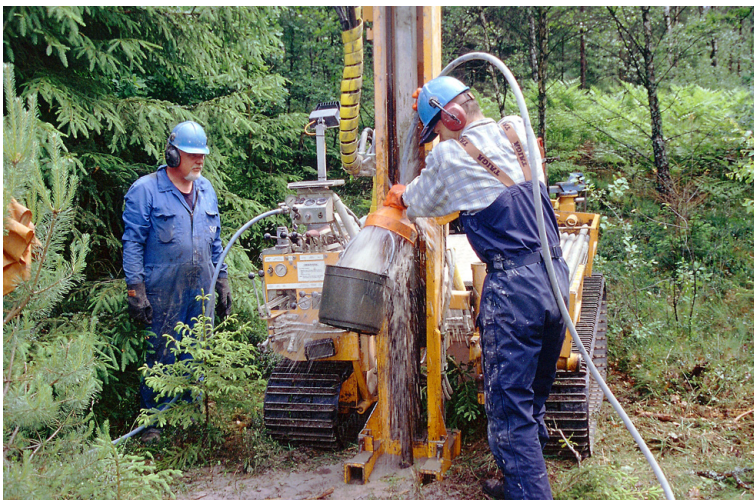
Fig. 6. När de geofysiska profilerna avvägts och utvärderats genomförs borrhinar på de mest intressanta platserna. Därvid undersöks och prov-tas såväl jordlagren som grundvattnet allt eftersom borrhiningen drivs djupare. Foto: C.-F. Müllern.
