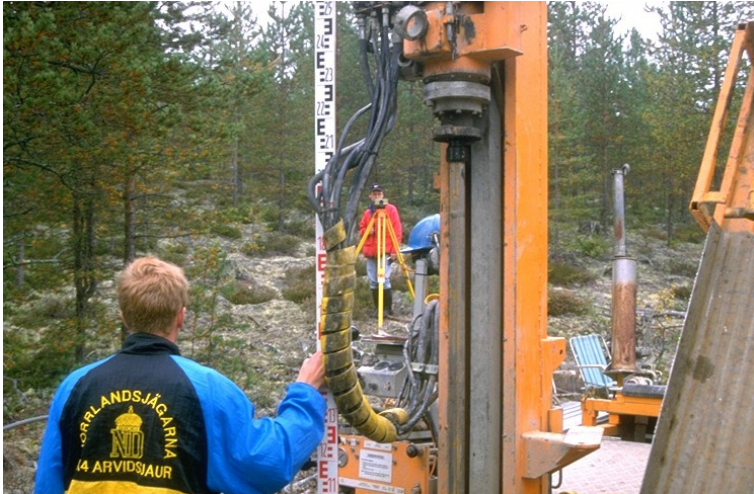
Fig. 5. Geofysiska profiler och observationsrör avvägs för att exakta nivåer på markyt, jordartsgränser, grundvattenytor och bergytor ska erhållas. Foto: T. Wikner.
