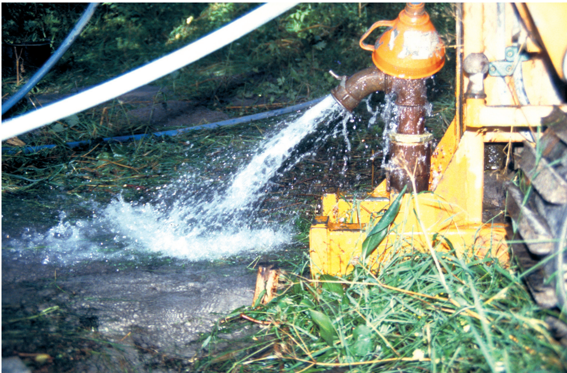
Fig. 7. Rensning är en viktig del i samband med etablering av observationsrör och rörbrunnar. Härvid spolas det finkorniga jordmaterialet upp till ytan och ett filter byggs upp omkring rörspetsen eller brunnens filterdel. Efter rörrensningen företas provpumpning i röret eller brunnen. Foto: C.-F. Müllern.
