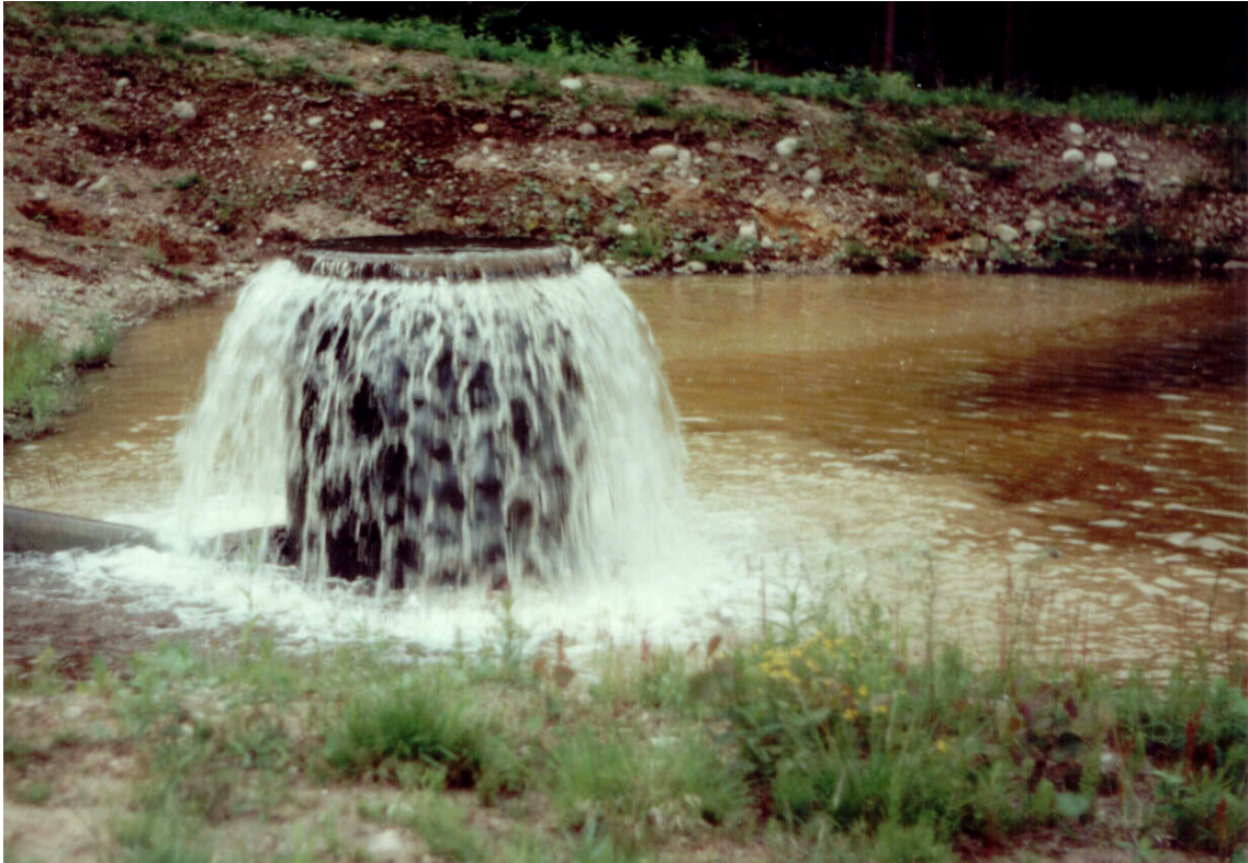
Fig. 12. Luftningsanläggning i infiltrationsdamm vid Kristinehamns vattentäkt vid Bergsjön. Järnet oxideras vid kontakt med luftens syre och faller ur som roströda avlagringar. Foto: Thomas Aneblom.
