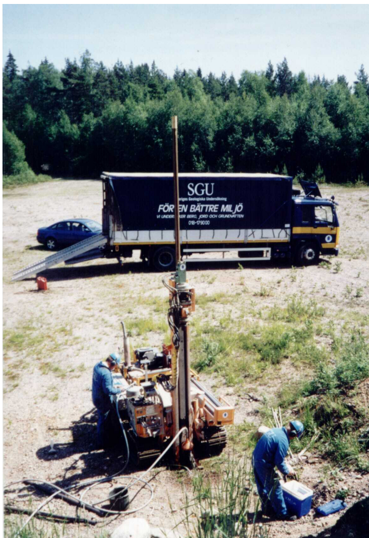
Fig. 33. Rörsättning i grustaget vid Hultängen (rör 9903). Foto: Heidi Graeffe.
