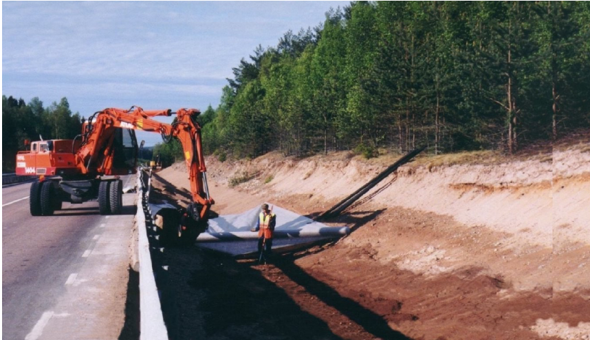
Fig. 45. Tätning av vägsidor på väg 64 vid Kristinehamns vattentäkt vid Bergsjön. Järnvägen som går strax till vänster om landsvägen är dock fortfarande inte skyddsåtgärdad. Foto: Curt Fredén.
