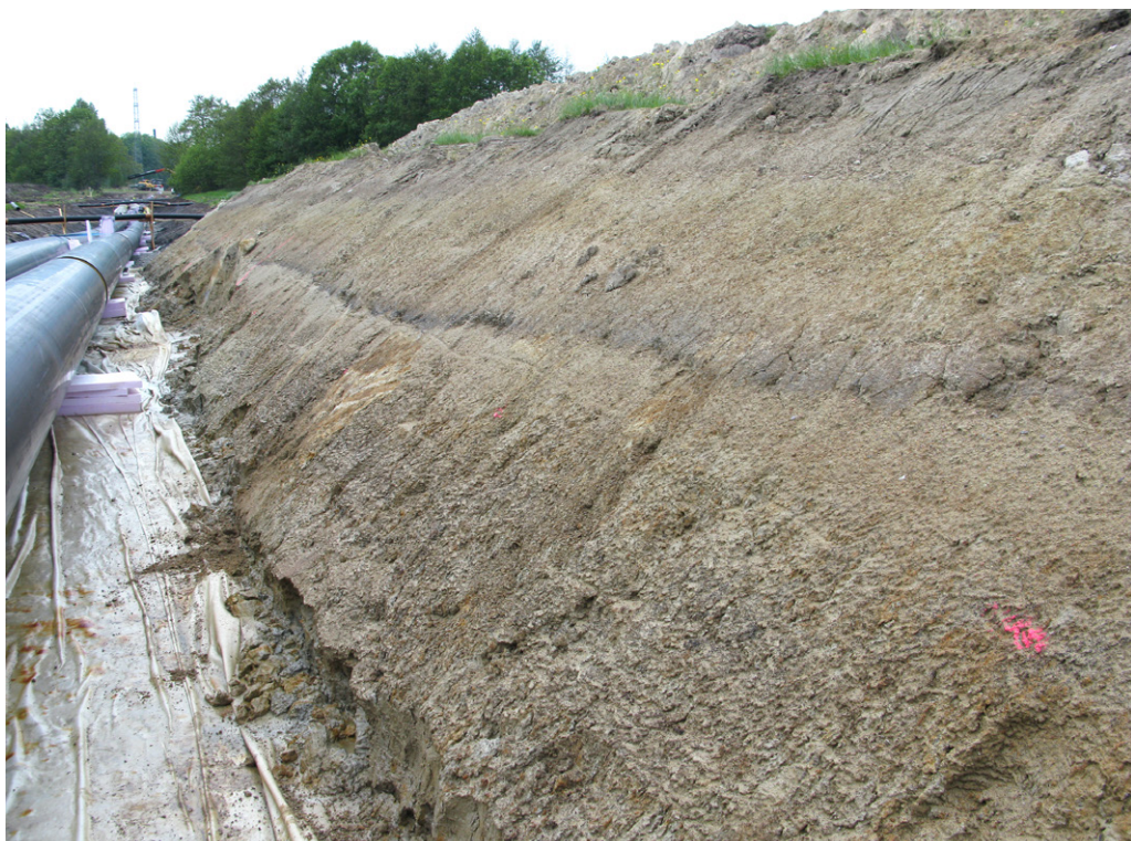
Figur 47. Gyttjan kilar ut mot uppförslutet och övergår i ett tunt skikt med humusfärgad sand. Foto: Magnus Persson.
