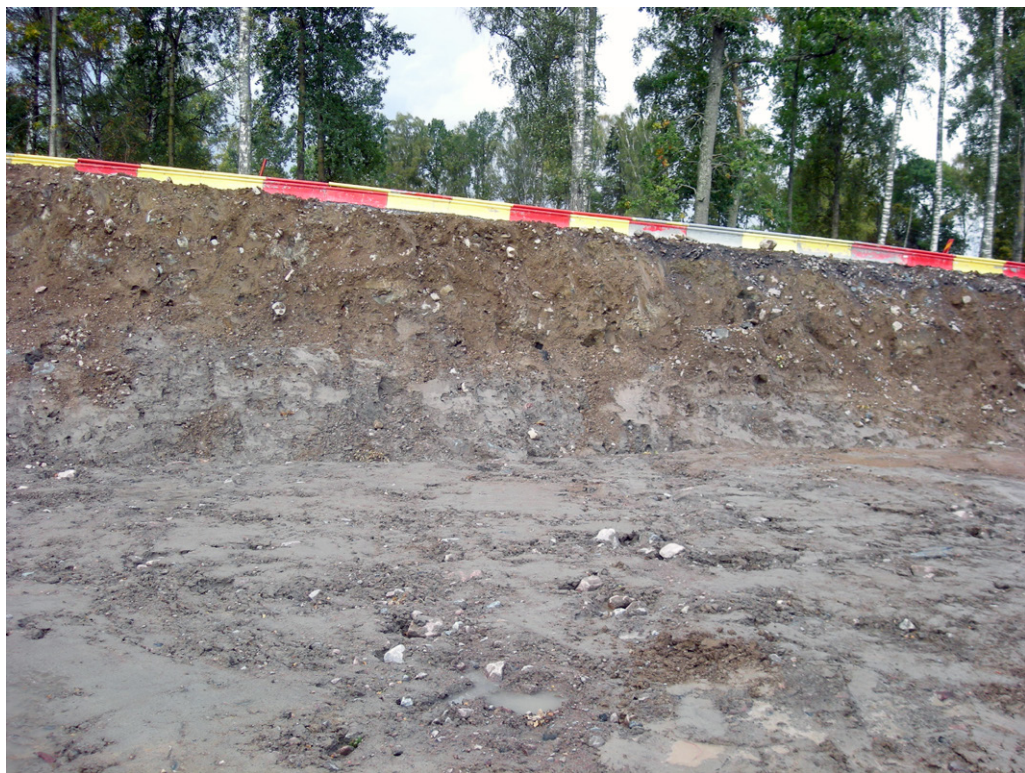
Figur 33. Vid ombyggnaden av E20 vid Gullhammar (7 d) blottades en skärning bestående av omväxlande lager av deformerad lera och morän. Foto: Tore Påsse.
