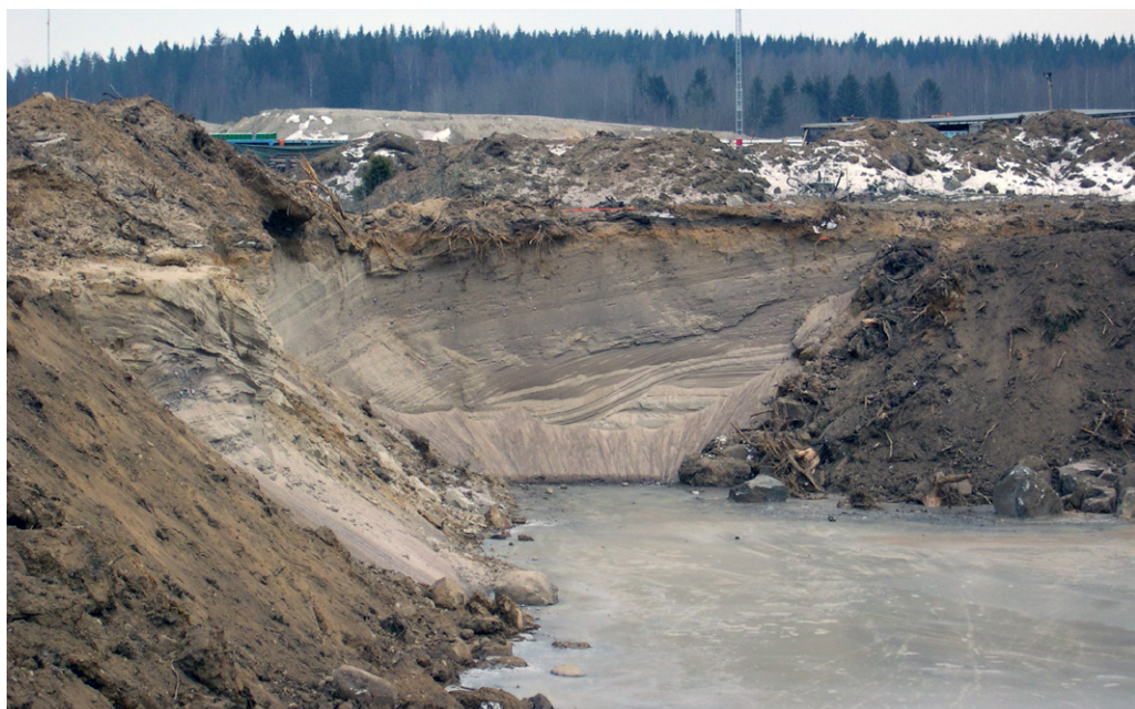
Figur 53. Sandiga lager, som blottades vid byggnationen av underfartstunneln vid väg 26 söder om Skövde. Foto: Tore Påsse.
