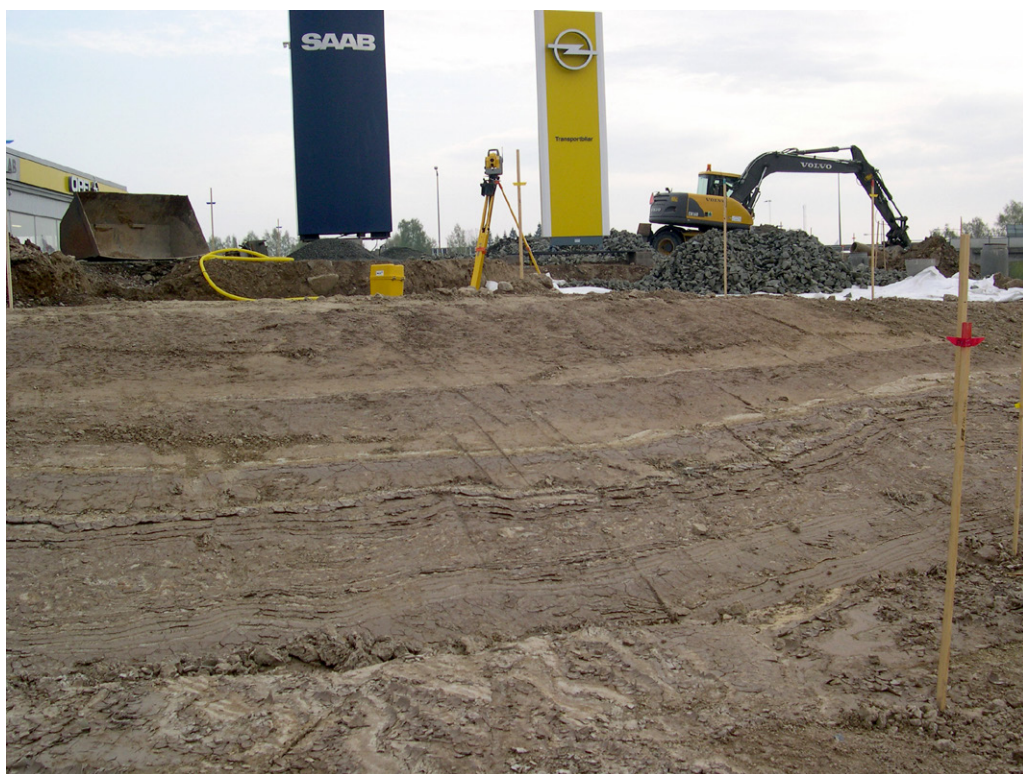
Figur 65. Varvig lera i centrala Skövde. Den nedersta delen av lagerföljden i bilden uppvisar kraftiga deformationer, som sannolikt har tillkommit genom en isframstöt. Foto: Tore Påsse.
