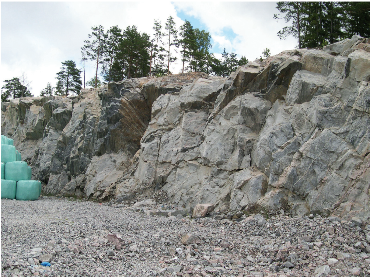
Fig. 1. Bergtälkten vid Löt. I tälkten bryts en folierad, fint medelkornig granit–granodiorit, en yngre, jämnkornig, fint medelkornig granit samt en finkornig, folierad metabasit. Granitoiderna är provtagna. Bergkvalitetsklass 2 (väg). MPA030002 (6614955/1641645).
