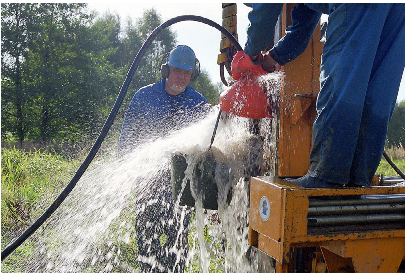
Fig. 13. Fortsättningen av borrhningen R 0110 visade allt bättre grundvattenförhållanden. Mellan 14 och 24 m var vattengenomsläppligheten mycket god. Allra bäst var förhållandena mellan 20 och 24 m med snabb vattenklarning, vilket visar på mycket liten mängd finkornigt material i dessa lager. Borrpunktens läge visas i figur 32. Foto: C.-F. Müllern.
