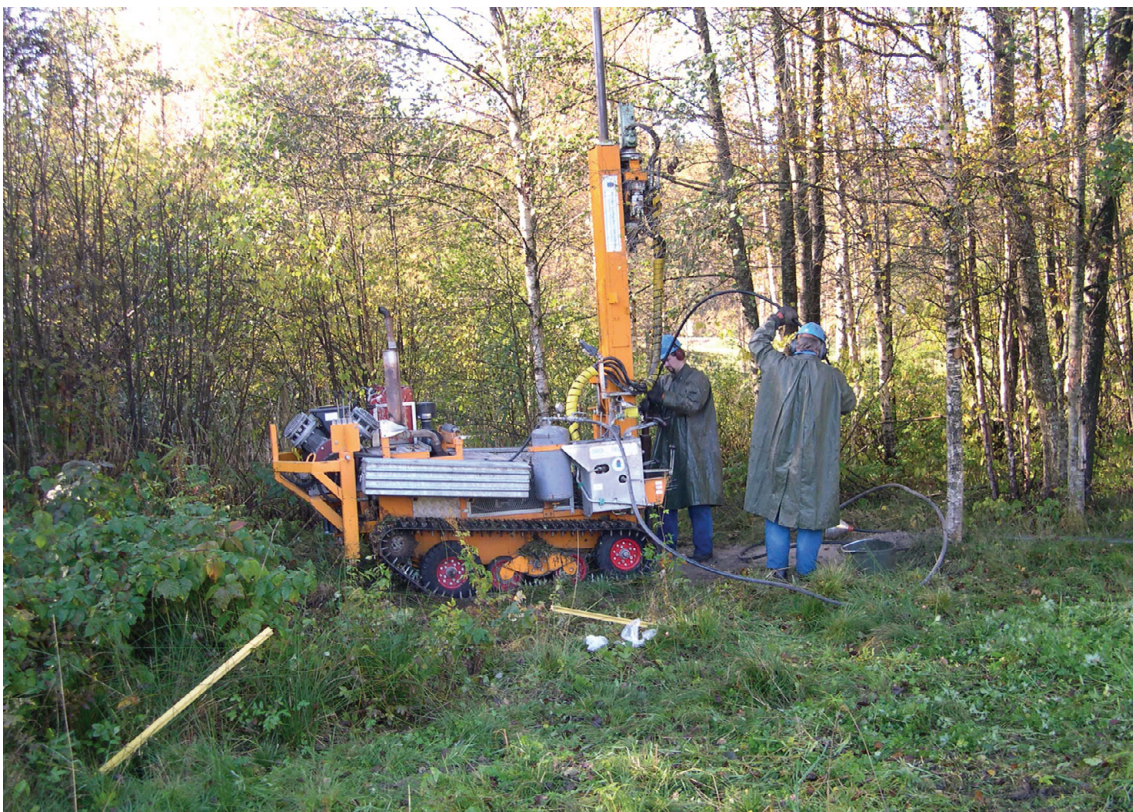
Fig. 3. Utförd undersökningsborrning med drivning av observationsrör SGU R0301. Borrplatsen ligger på det plan väster om Inseros som visas i figur 2. Foto: Torbjörn Persson.
