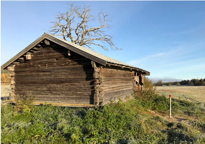
Figur 3. Grundvattenrör BMW181005 vid Åsgårdsbäcken nära Ljusnans strand, i magasinets norra del. Foto: Charlotte Defoort, SGU.
