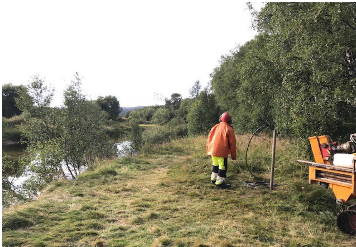
Figur 5. Installering av grundvattenrör Rb21002 i grundvattenmagasinet Svallmyren norra. Fotografi taget mot norr. Foto: Elisabeth Magnusson, SGU.
