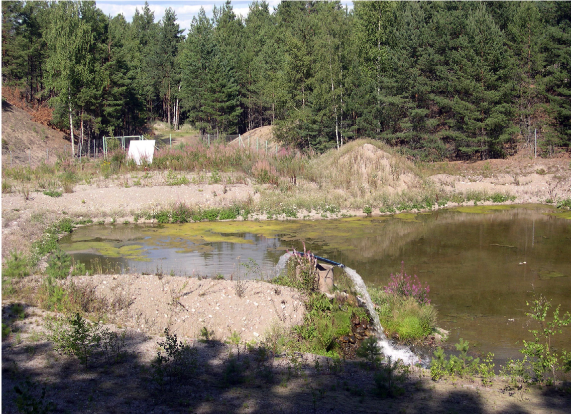
Fig. 9. Infiltration av Mälarvatten vid Skytteholms kommunala grundvattentäkt. Den konstgjorda grundvattenbildningen medför bland annat ett mjukare rävatten. Foto: Torbjörn Persson.
