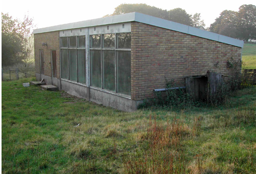
Fig.11. Det nedlagda vattenverket i Årnarp. Foto: M. Gustafsson.
