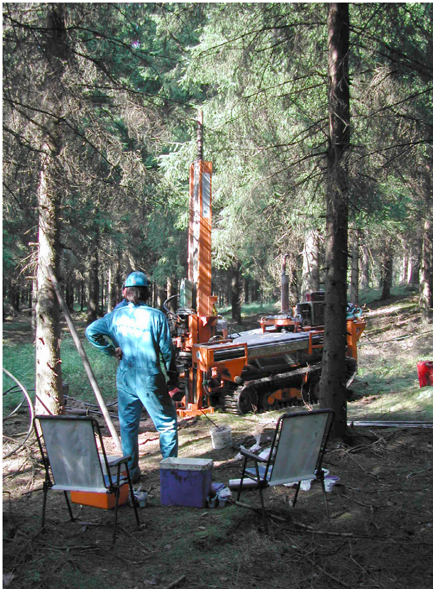
Figur 6. Borrning av grundvattenrör R 0301. Foto M. Gustafsson.
