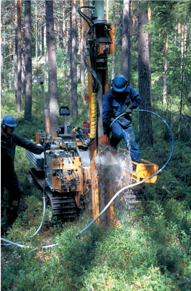
Fig. 5. När de geofysiska mätningarna avvägts och utvärderats genomförs borrhningar på de mest optimala platserna. Därvid bestäms sammansättningen på jordlagren allteftersom borrhningen drivs djupare. Foto: C.-F. Müllern.
