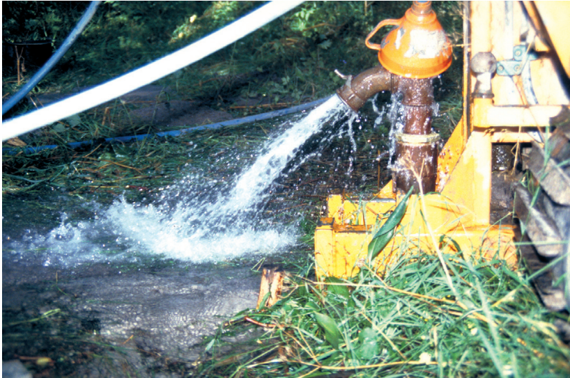
Fig. 7. Rensning är en viktig del i samband med etablering av observationsrör och rörbrunnar. Härvid spolas det finkorniga jordmaterialet upp till ytan och ett filter byggs upp omkring rörspetsen eller brunnens filterdel. Efter rörrensningen kan provpumpning företas i röret eller brunnen. Foto: C.-F. Müllern.
