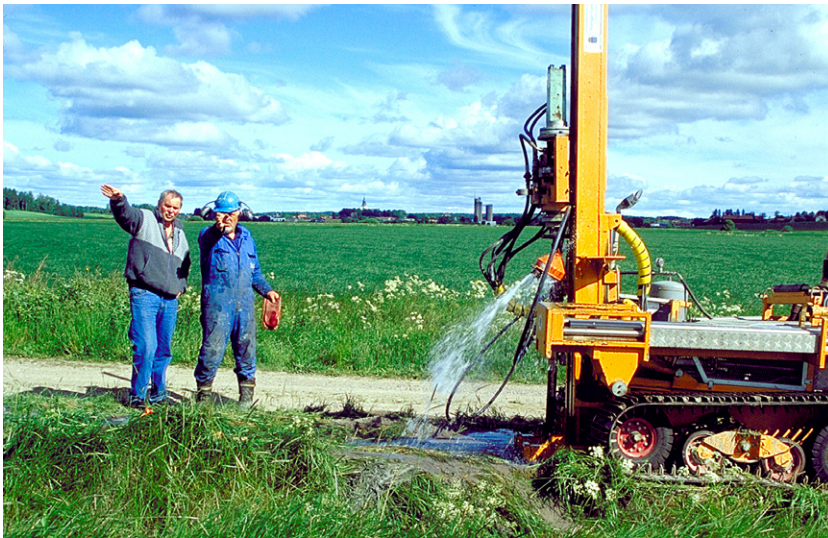
Fig. 21. Grundvattenmagasinet nets fortsättning från Röck- linge mot söder pekas ut. Åt andra hållet sträcker sig detta grundvattenmagasin under åkrarna till Heby samhälle i bakgrunden. Foto: C.-F. Müllern.
