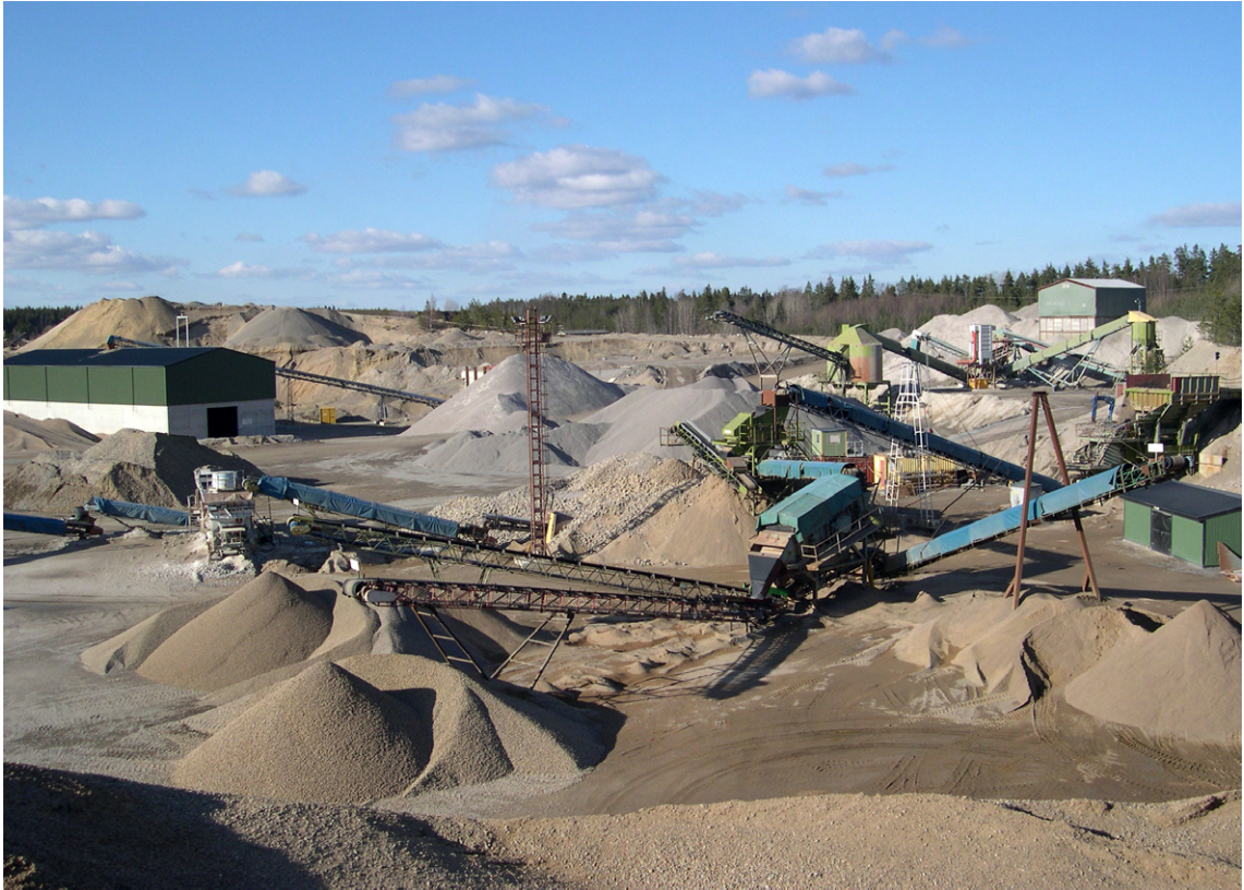
Fig. 11. Grustäktsverksamhet i Riksten i anslutning till Pålamalms mellersta och norra grundvattenmagasin. Foto: Torbjörn Persson.
