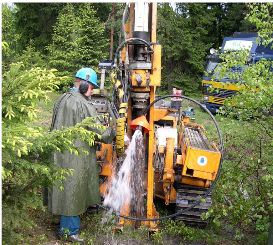
Fig. 4. Efter utvärdering av de geofysiska undersökningarna utförs borrhning på ett urval platser. I samband med sättning av grundvattenrör kan jord- och vattenprover tas för analys från intressanta delar av lagerföljden. På bilden etableras ett grundvattenrör strax väster om sjön Axaren. Foto: Torbjörn Persson.
