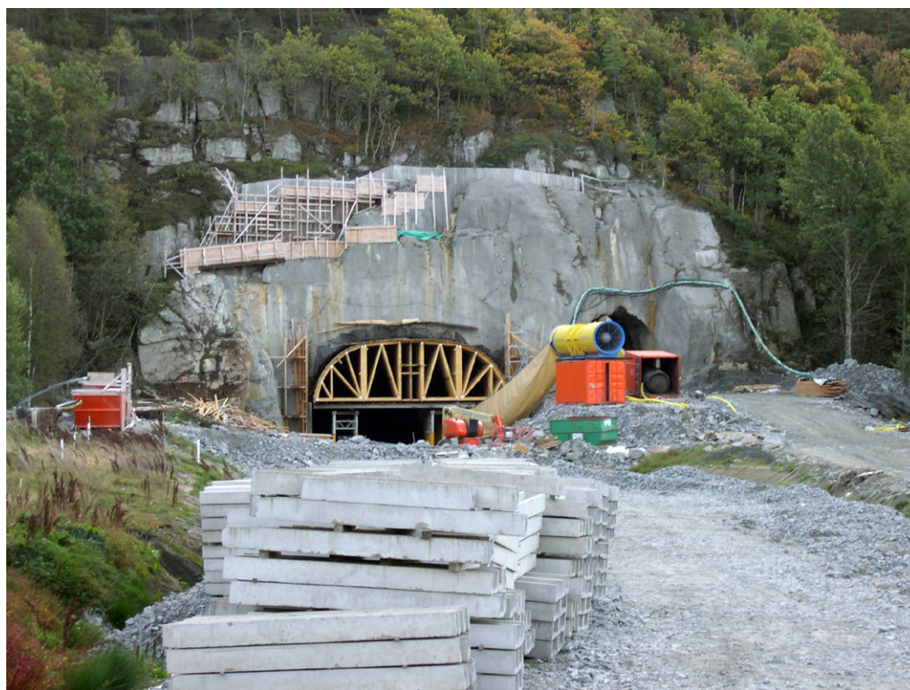
Fig. 2. Järnvägstunnelbygget vid Åsa (DCL032023, 6565284/1279321) har genererat ca 750 000 ton makadam och är ett viktigt komplement till traditionell bergmaterialproduktion från täkter. Foto Dick Claesson.
