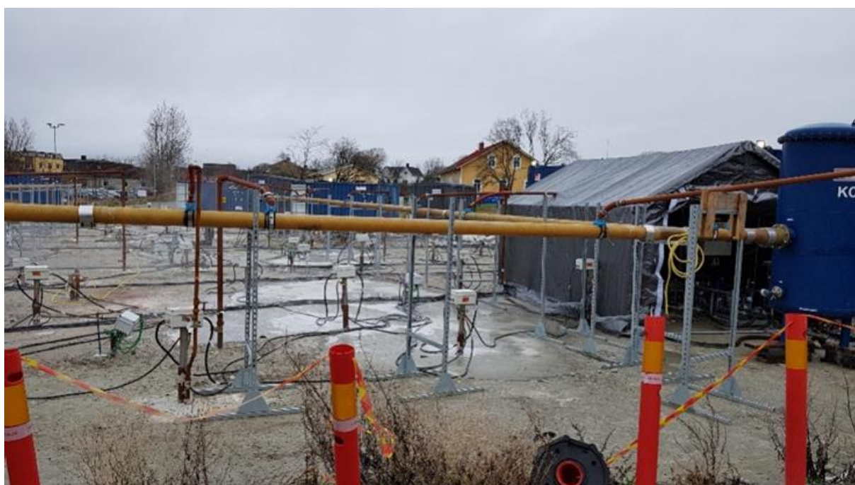
Figur 25. Bilden visar område inom vilket termisk åtgärd pågår. Ytan är här tätad med betong.
