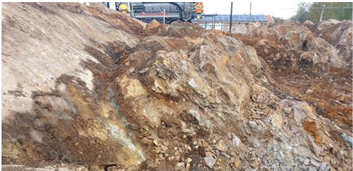
Figur 26. Exempelbild (OBS! Ej från det aktuella området!) på hur bergöverytan och således även schaktbotten antas se ut. Foto: Wiktor Skoglund.
