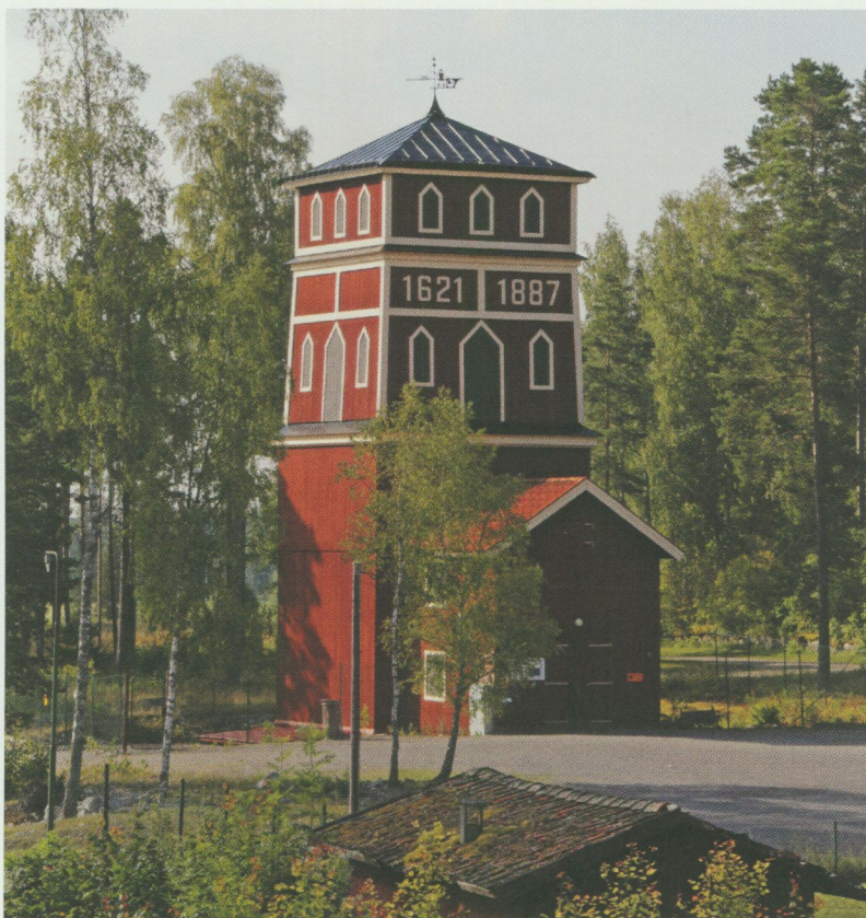
Från den återuppbyggda laven över Knechtschaktet i Sala silvergruva kan man åka hiss ned till 155-metersnivån.
