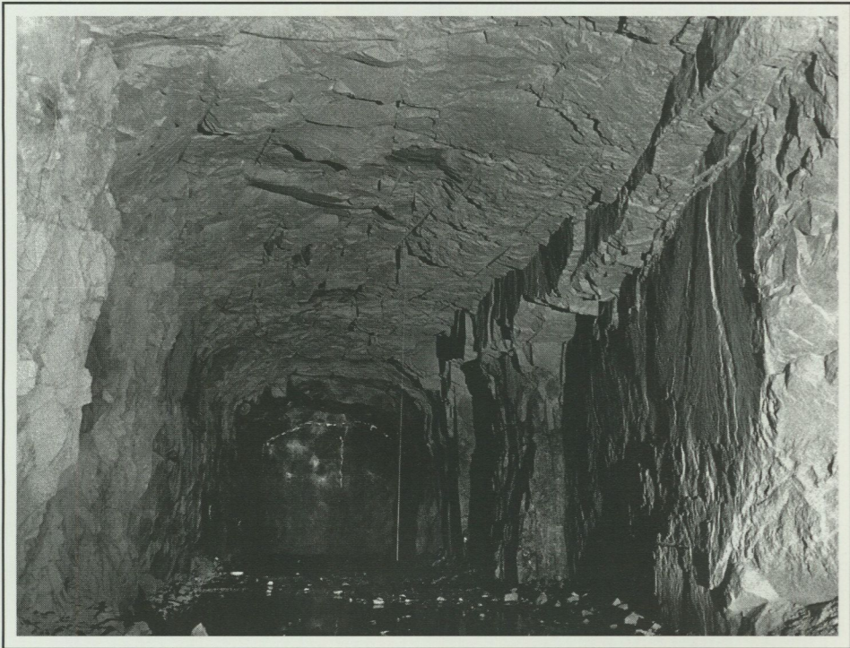
Sprickplan i granitisk berggrund på 20 meters djup. En del av sprickorna i taket är orsakade av sprängning. Foto: Carl-Olof Morfeldt.
