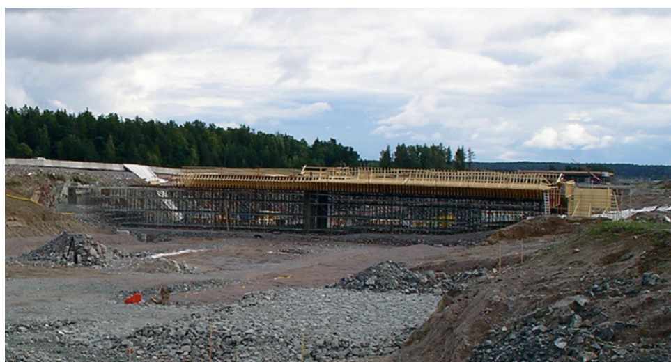
Bygge av korsande bro av betong för påfart till nya E4:ans dragning öster om Uppsala. Foto: Åke Berg.
