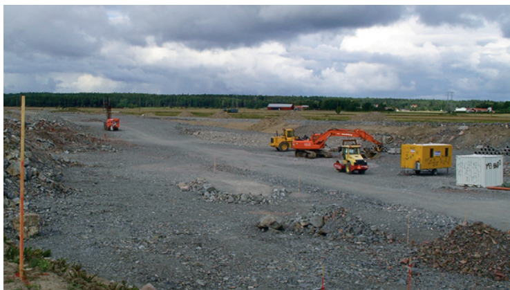
Pågående motorvägsbygge strax öster om Uppsala. Ny dragning av E4-an förbi Uppsala och norrut mot Mehedeby blir klar år 2007. Foto Åke Berg, SGU.
