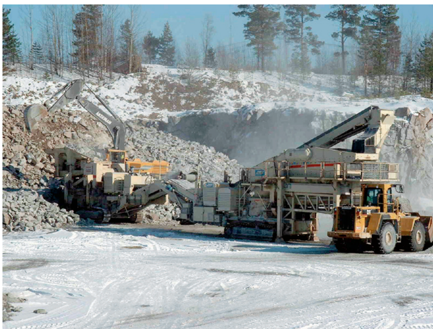
Mobila krossar används bl.a. i samband med vägbyggen för att krossa och använda på plats det berg som ligger i anslutning till det planerade vägbygget. Foto: Sveriges Bergmaterialindustri, Bildarkivet.
